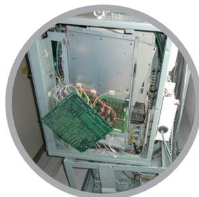
地震被害例2（制御盤移動）
